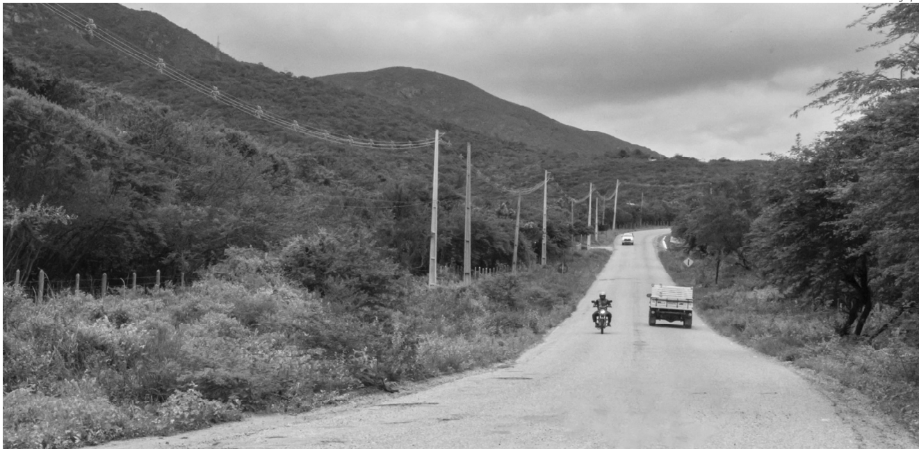
Cuidado com as pessoas: Obras trarão maior segurança para o tráfego na via
