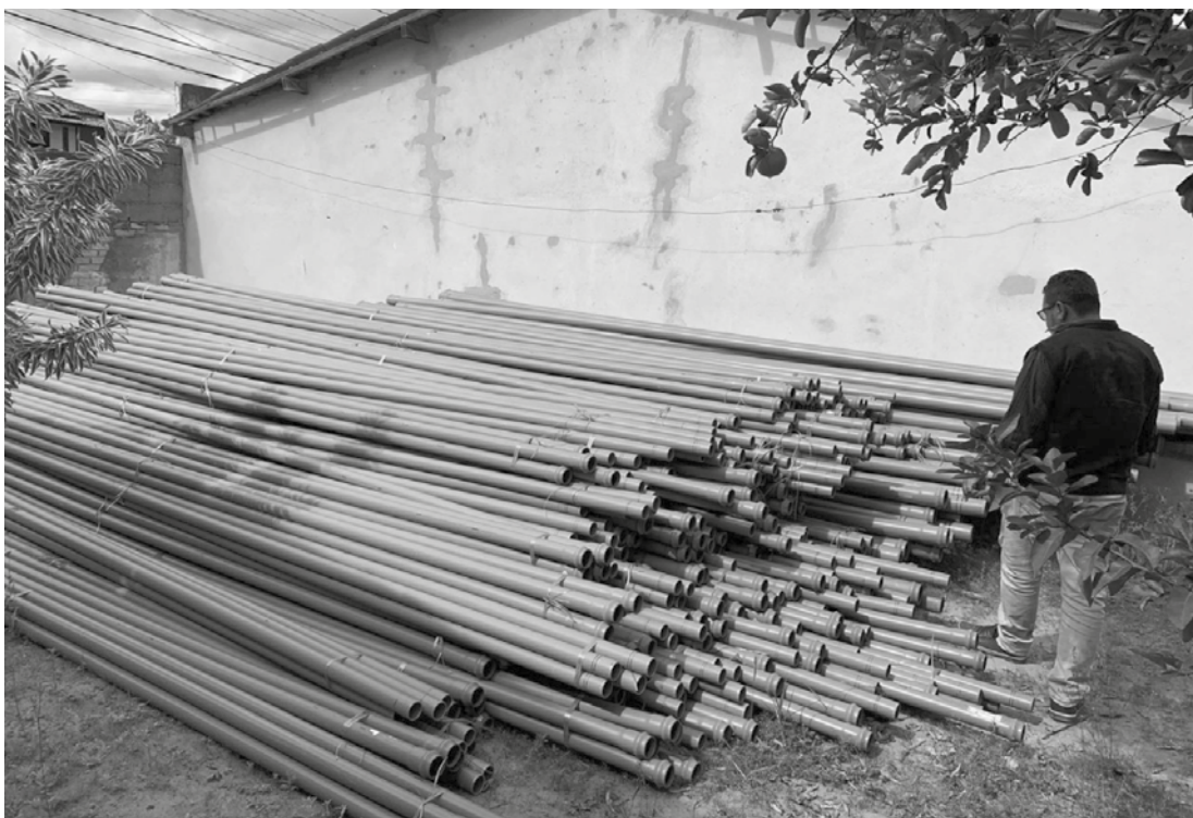
Serão instalados 7 km de tubulações na região
