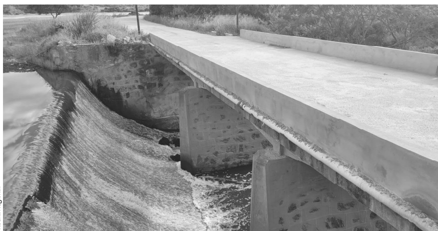
A ponte que dá acesso ao povoado também foi restaurada após vários anos
